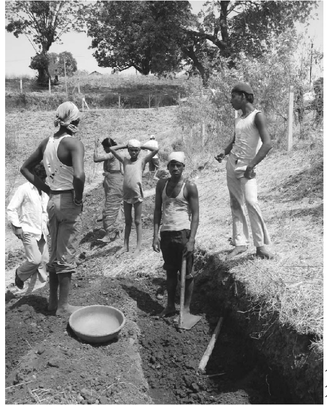
कण्टूर लाइनों के साथ खाइयों की खुदाई
